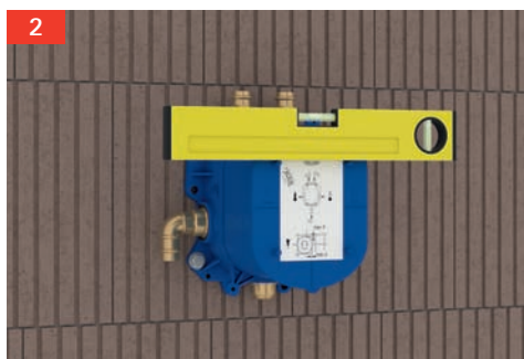
2 Wypoziomuj element podtynkowy Oznacz otwory do wywiercenia i zamontuj skrzynkę montażową
