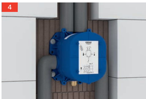
4 Przygotuj odpowiednią wnękę Zwróć uwagę na oznaczenia właściwej głębokości montażu
