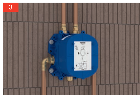
3 Połącz i uszczelnij rury Sprawdź połączenia Dokładnie przepłucz rury
